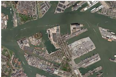
Luchtfoto van de Rotterdamse Stadshavens.
