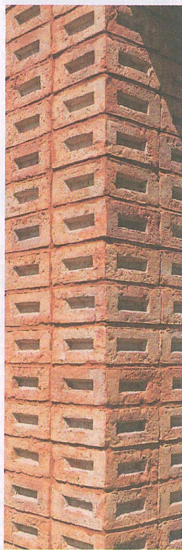
Het metselverband gaat dankzij de in verstek gezaagde en aan elkaar gelijmde hoekstenen strak de hoek om.
