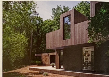
Vanaf deze kant oogt het huis niet zo groot als het blijkt te zijn. Het dak van de carport (3,5 m) is een uitkraging van een 11 meter lange plaat CLT.
