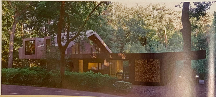
Vanaf deze kant oogt het huis niet zo groot als het blijkt te zijn. Het dak van de carport (3,5 m) is een uitkraging van een 11 meter lange plaat CLT.
