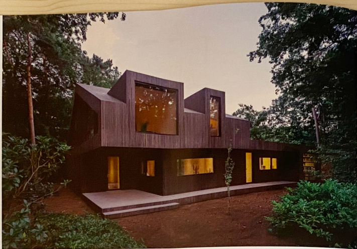
Een overstek bij de woningtree van 3,5 bij 5 meter zonder ondersteuning is mogelijk met kruislaaghout. Hier draagt de vloer uit en hangt aan de bovenliggende wanden.
