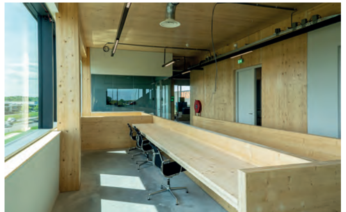
Ook in het vaste meubilair is CLT toegepast, zoals bij deze wisselwerkplekken.
