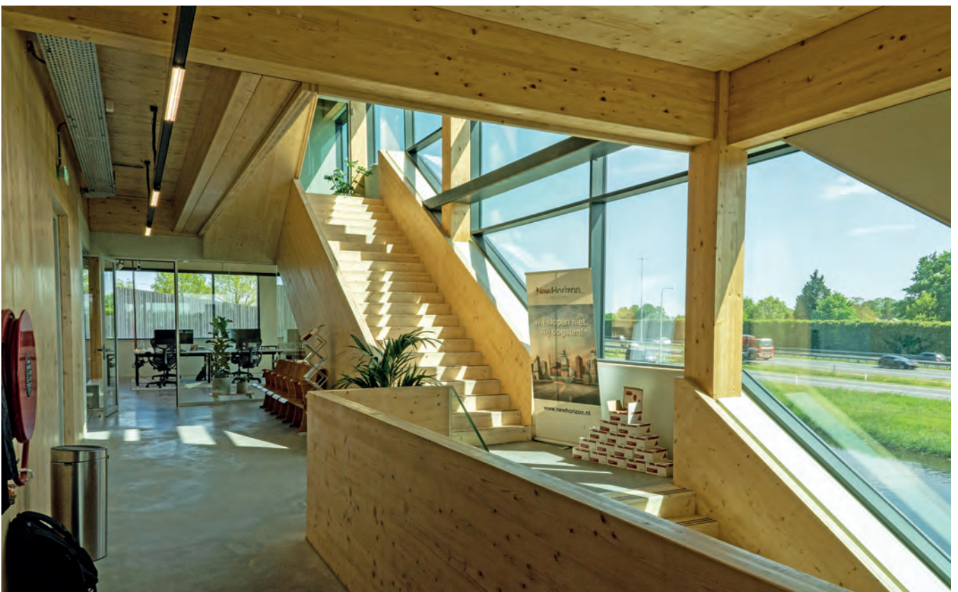
De CLT trappen naar de eerste en tweede verdieping liggen in elkaars verlengde langs de zuidgevel.
