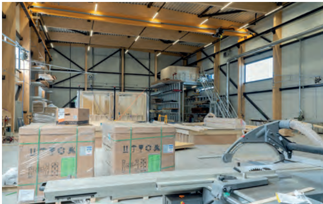
De constructie van de hal van gelamineerde houten kolommen en liggers is versterkt met stalen schoren.
