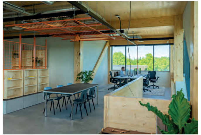
De kantoren zijn afgewerkt met gipsplaten wandbekleding en zwevende circulaire dekvloeren.
