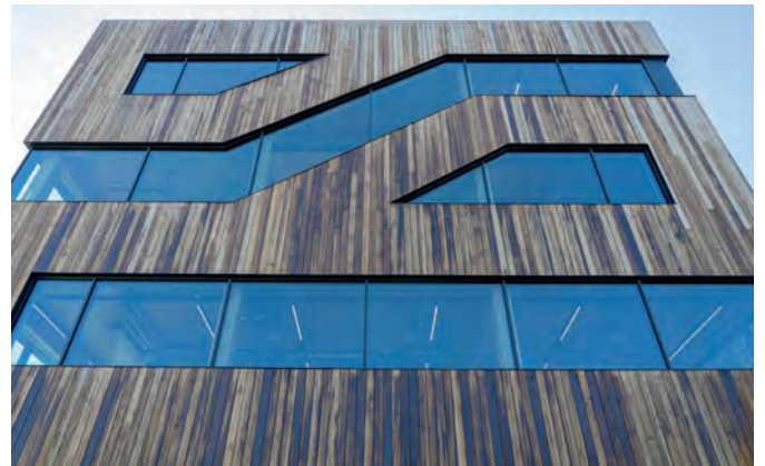
De aluminium vliesgevel is ten opzichte van de frakégevel iets teruggelegd zodat de houten banden rondom beter tot hun recht komen.
